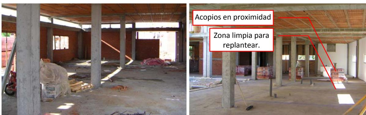
Figura 25. Fotografía interior obra, antes y después de limpiar. Fuente: Elaboración propia.
