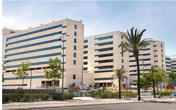
Ilustración 41: Nuevo hospital LA FE de Valencia.
