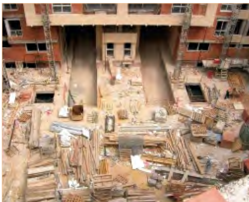
Figura 1. Obra de Edificio de Viviendas, año 2006
